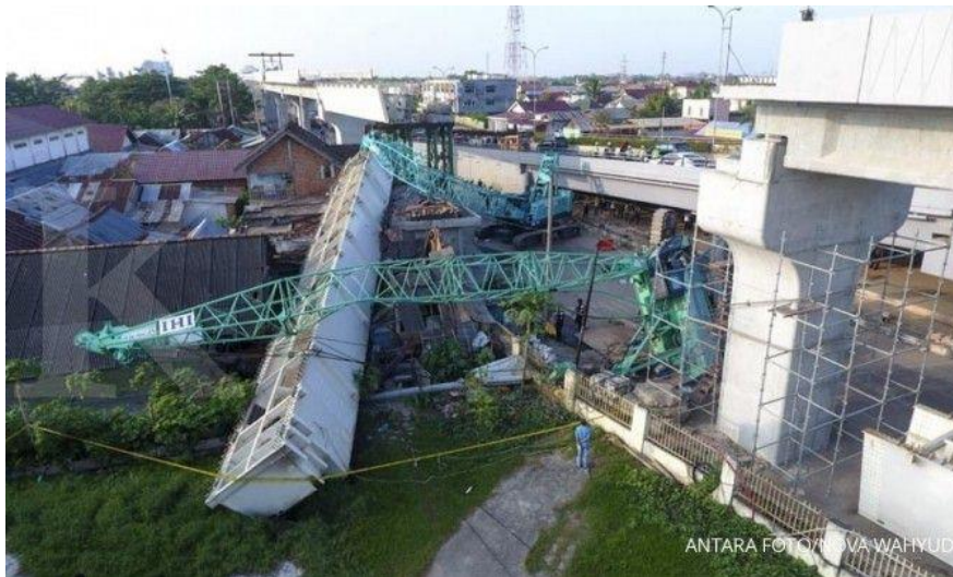
Gambar 1. Jatuhnya Crane LRT di Palembang, (nasional.kontan.co.id)
