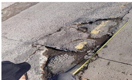
Gambar 5 Retak Berlubang
