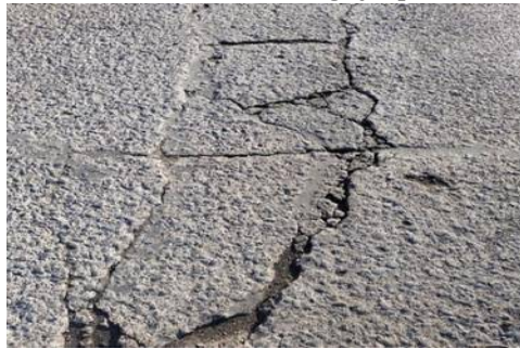
Gambar 3 Retak Pumping
