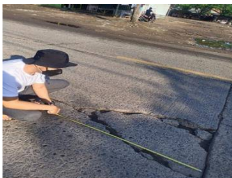
Gambar 1 Retak Sudut
