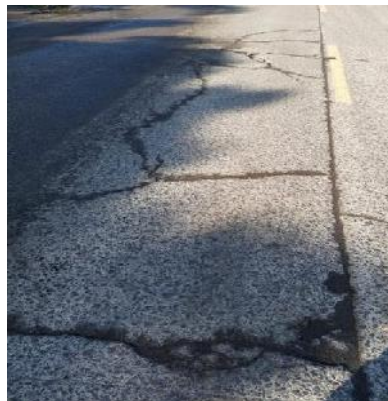
Gambar 4 Retak Memanjang
