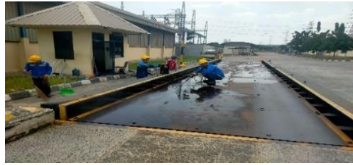
Gambar 2. Pembersihan Komponen Jembatan Timbang
