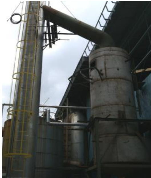
Gambar 10. Pemasangan Wet Scrubber
