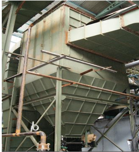
Gambar 8. Pemasangan Unit Multi Cyclone
