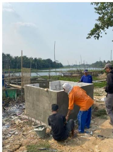
Gambar 2. Proses pembuatan bak sampah di wilayah RW 02
