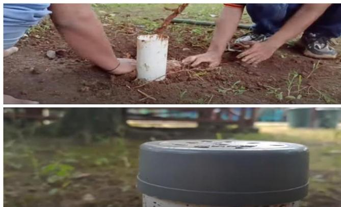
**Gambar 6. Pembuatan lubang biopori**
